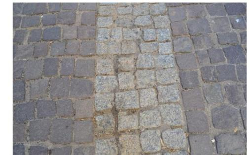
Pavimentazione in blocchi scuri di granito sbazzati e fascia centrale in blocchi lapidei chiari
