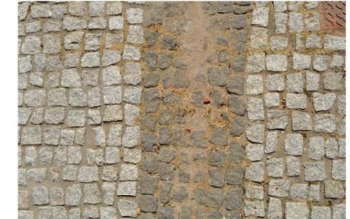
Pavimentazione in blocchi chiari di granito sbazzati e fascia centrale in blocchi lapidei scuri
