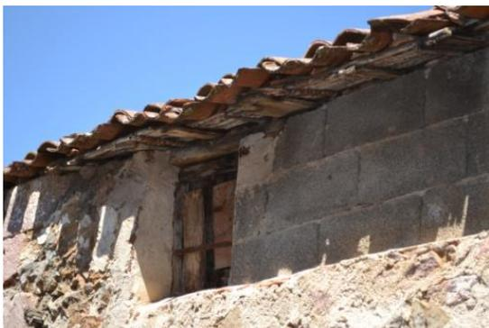
**SISTEMA DI RACCOLTA** A\_Soluzioni prive di dispositivi di raccolta delle acque meteoriche
