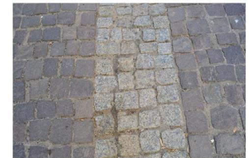
Pavimentazione in blocchi scuri di granito sbazzati e fascia centrale in blocchi lapidei chiari
