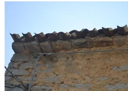
**SISTEMA DI RACCOLTA** A\_Soluzioni prive di dispositivi di raccolta delle acque meteoriche
